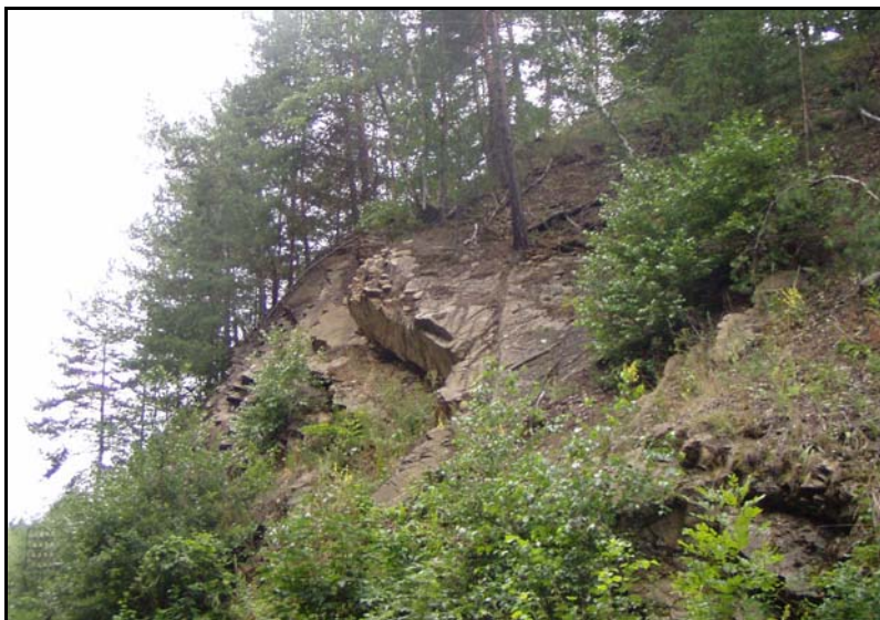
Foto 4 – postupně se uvolňující lavice v km cca 11,995
