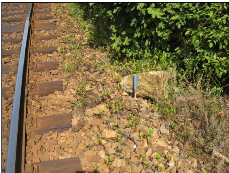
Foto 7 - Detail - upadlý fragment v patě svahu odřezu
