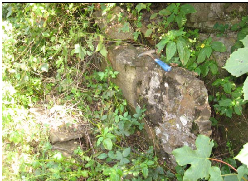
Foto 5 - Detail - sesunutý balvan v patě odřezu v km 11.700
