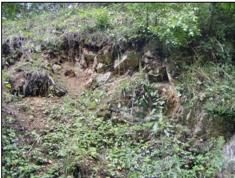
Foto 4 - Detail - opadávání fragmentů ze svahu v km cca 11,950
